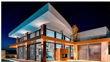
The Wavehouse. Passivhaus certificada. Consultoría Passivhaus Monteromero - Costa del Sol
